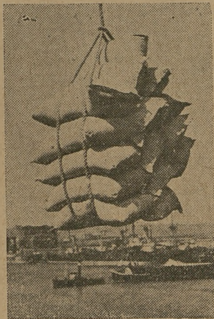
Tzw. „chiw” — porcja towaru uniesiona przez pracujący dźwig drobnicowy.
