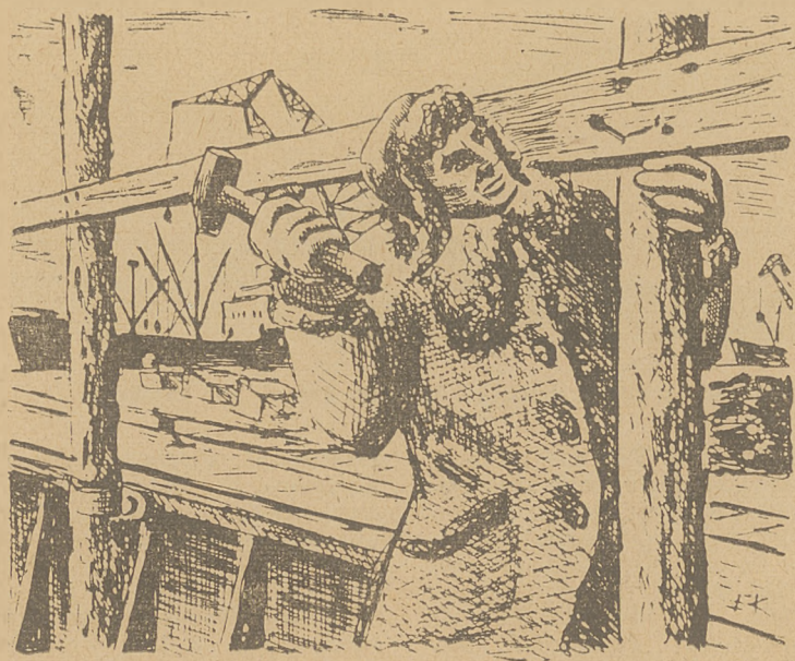
...dwóch marynarzy nosi słupy, zakłada je w klamry, jeden przybija deski wzdłużne...
