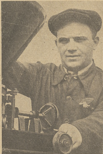
WOJCIECH OFIARA wymyślił przyrząd samotrymujący do łowarów sypek. Ma on zastąpić ciężką pracę trymerów
