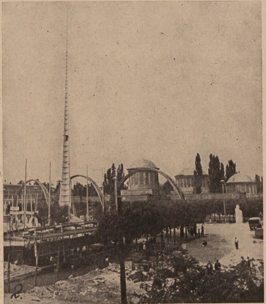
Strzelista, 106-metrowa iglica i 3 łuki, otwierające widok na tereny Wystawy Ziemi Odzyskanych, są symbolem osiągnięć naszego przemysłu w ciągu 3 lat. Wystawa we Wrocławiu jest dowodem sukcesów naszej pracy.
