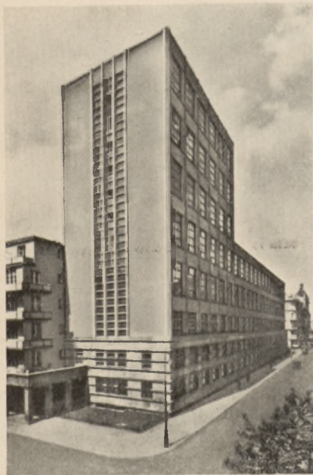
Warszawa. Nowy gmach Telefonów Międzymiastowych.
