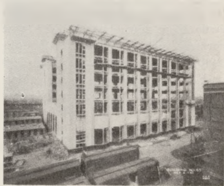
Fig. 4. Budynek Tow. A. O. Smith Milwaukee w budowie.
