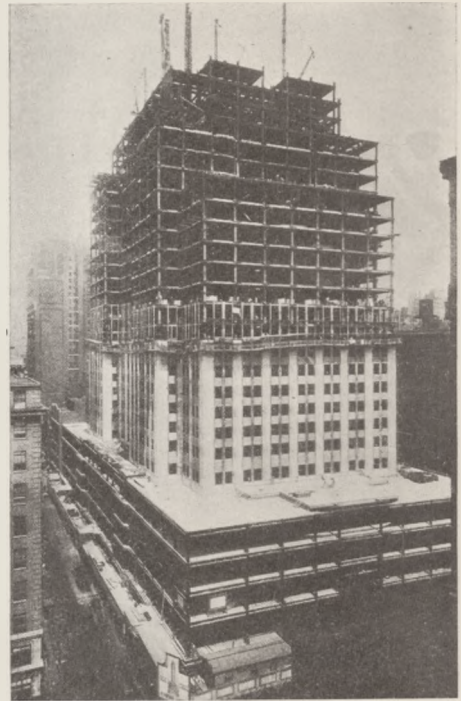
Fig. 5. Empire State Building w Nowym Yorku w budowie.
