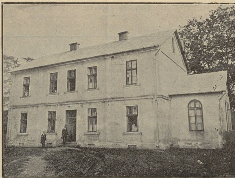
Budynek fabryki mieszkalny.
