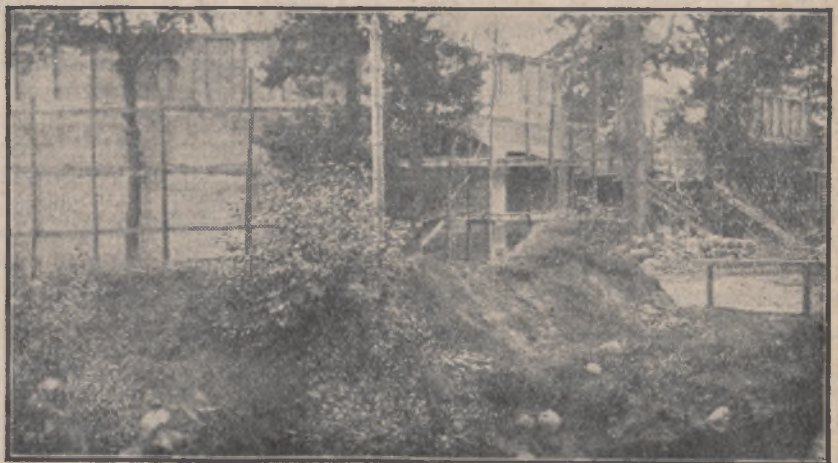
Budowa kanału napowietrznego — akweduktu.
