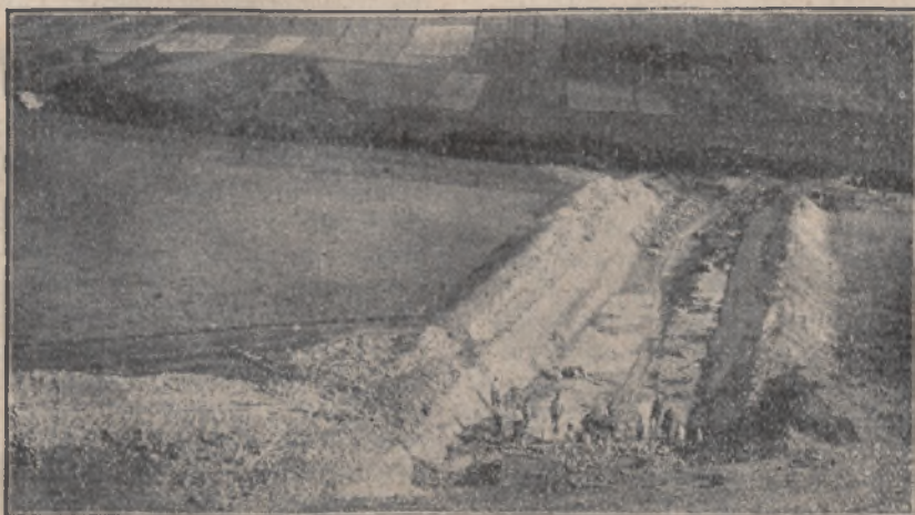
Budowa kanału ziemnego
