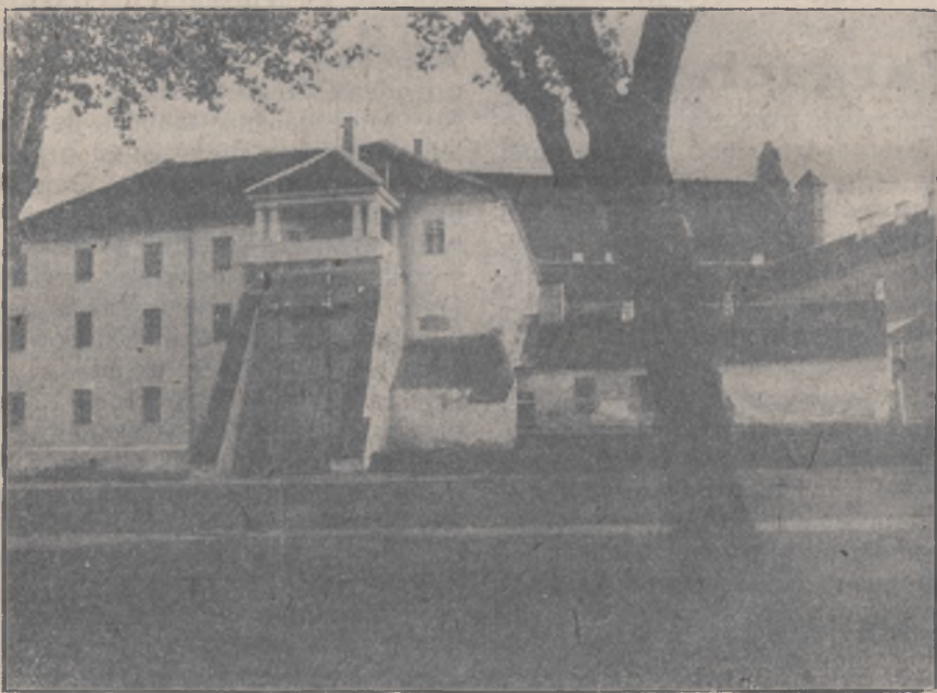
Widok odnowionych murów po-Bernardyńskich od strony pawilonu głównego.
