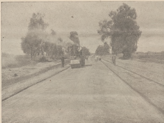
Bau eines Abschnitts der gewalzten Landstrasse Wilno—Lida—Slonim—Zubleszczyce. Vilnius — Lida — Slonimas — Zubleszczyces plento dalies statymas.
