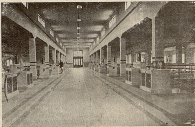
Widok hali filtrów pośpiesznych
