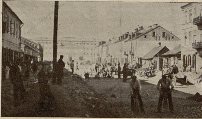
Siedlce. Fragment robót brukarskich na ul. Pięknnej
