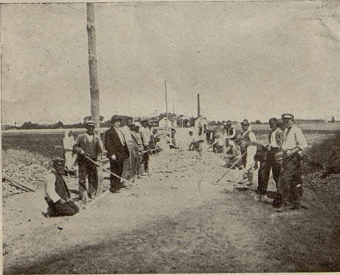
Praca przy budowie drogi bitej Elżbietów-Przywózki (gm. Kudelczyn)
