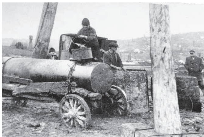
Prace przy wodobyciu ropy naftowej. Pierwszy z prawej strony Kajetan Batiuk
