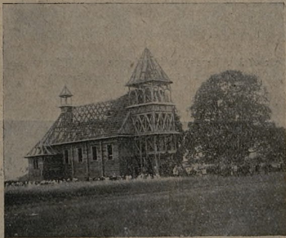
Kościół św. Teresy w Kamionce (w czasie budowy).
