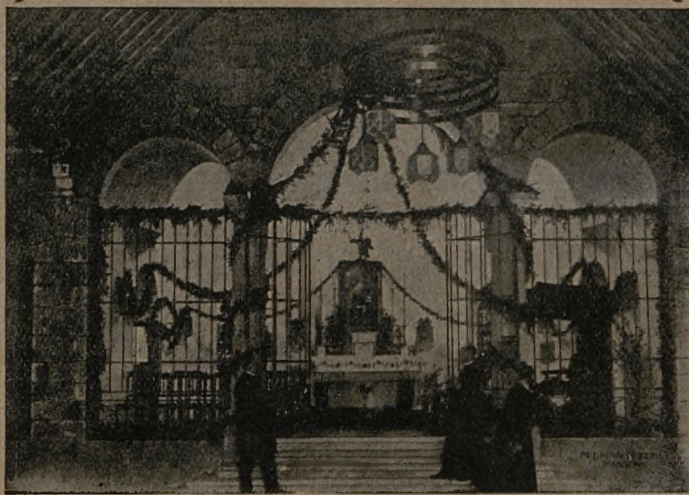
Część zimowa Kaplicy (widok z frontu).
