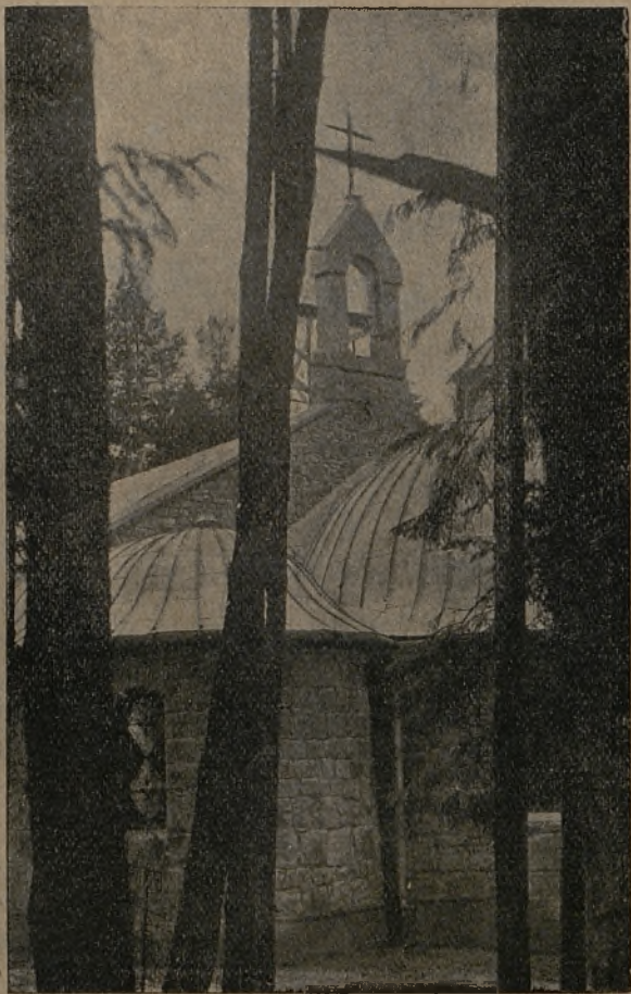
Część zimowa Kaplicy (murowana).
