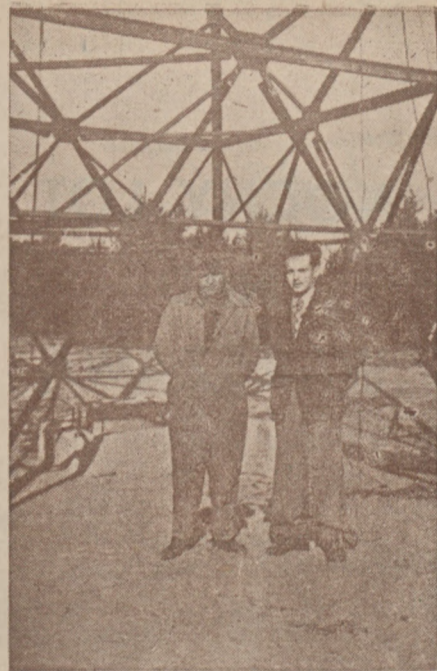
Brygadzysta Robert Duda, który kieruje budową wieży w Stalowej Woli i inicjator tej budowy Wł. Kólczyko.
