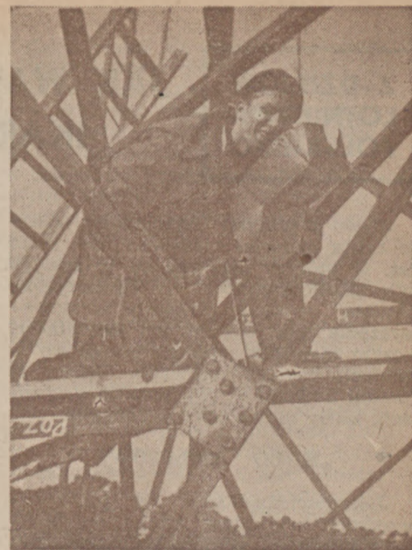
Przewodnikiem pracy przy montażu wieży spadochronowej w Stalowej Woli jest spawacz kolega Warchot.
