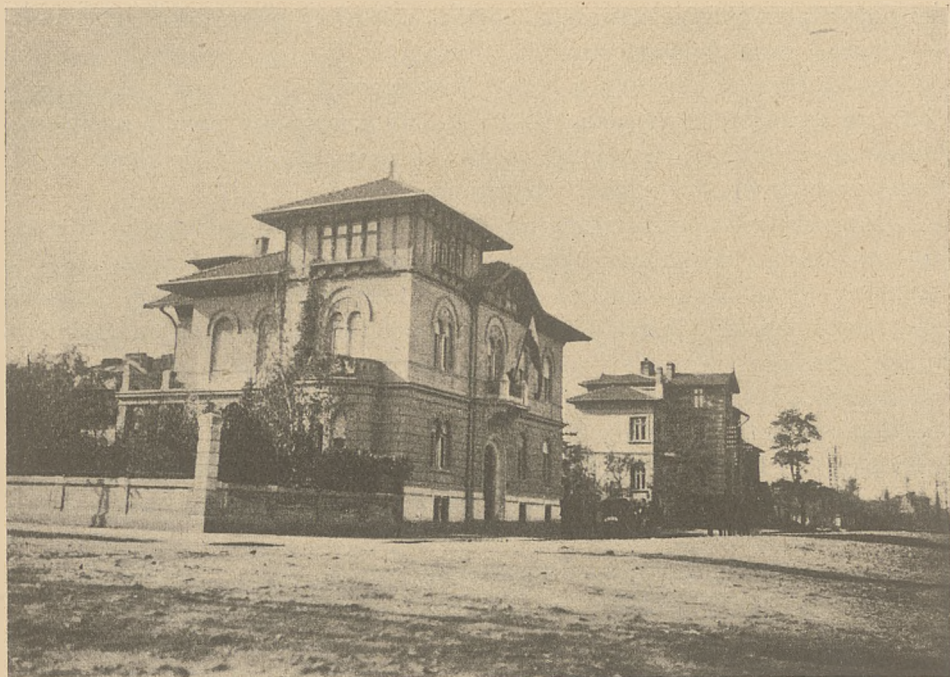
BUDYNEK POSELSTWA POLSKIEGO W SOFJI (Bulwar Patriarchy Eftimiego Nr. 35)
