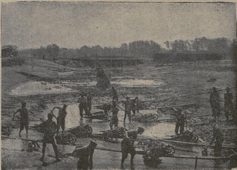
Budowa nowego koryta Przemszy.
