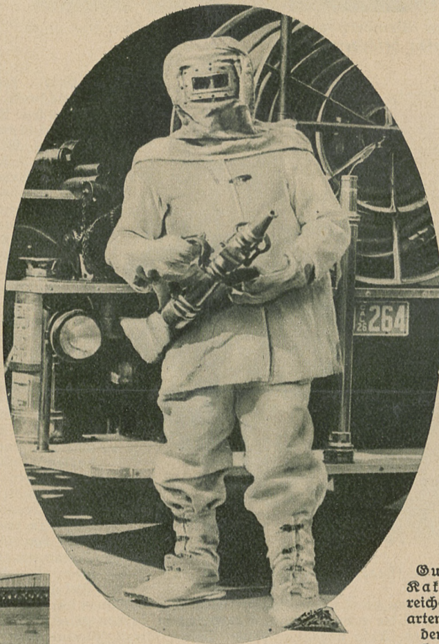
Eine neue A-Bestausrüstung für die amerikanische Feuerwehr. Der Anzug, der auch mit einem besonderen Schirm für die Augen versehen ist, befähigt den Mann, mitten in das Feuer hineinzugehen Atlantic
