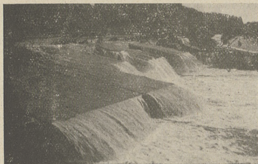
Das große Olshawehr bei Hochwasser.
