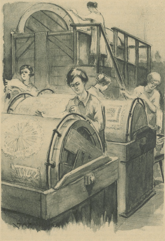
Die Behandlung von Spitzen und Gardinen, die mit Tausenden von Nadeln auf großen Walzenrollen festgesteckt sind
