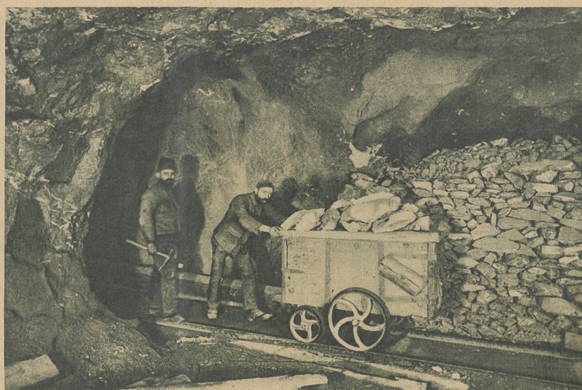
Erzförderung. Bergleute fördern die Erze von der Abbaustelle durch die Strecke im Förderwagen, auch „Dunt“ genannt, nach dem Schacht. Neben dem Wagen ist ein abgebauter Hohlraum durch laubes Gestein ausgefüllt.
