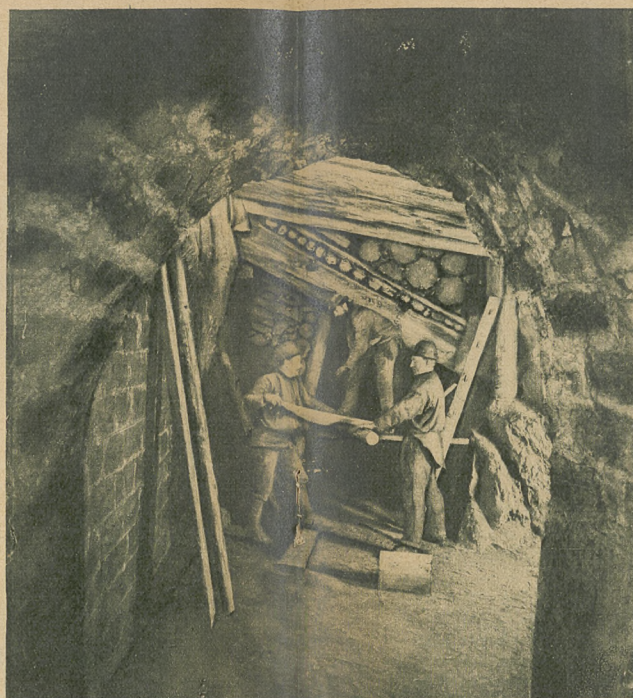
Stredenausbau. Im lockeren Gestein müssen Strecken und Grubenräume durch Verjämmerung, Mauerung oder Betonbau vor dem Zusammenbrechen gesichert werden. Bergleute bei der Verjämmerung eines Grubenraumes.
