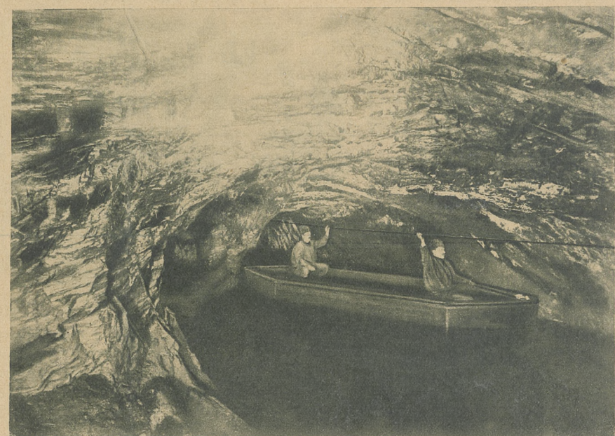
Erzförderung im Oberharz durch Schiffahrt. In Holz- und Eisenkähnen wurden bis vor 20 Jahren die Erze in Stäben auf der saßbaren „Tiefen Wasserstrecke“, 400 m unter Tage an den Schacht gebracht. Die beiden Bergleute ziehen das Schiff an dem unter der Decke des Stollens angebrachten Drahtseile.
