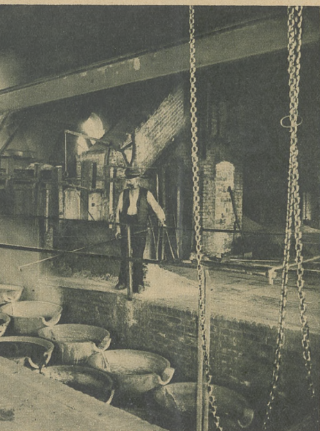
Flammofen zur Kupfererzkonzentration der Hütte zu Oler. Das Bild zeigt, wie kupferreicher Stein und Schlacke aus dem Ofen durch vertikal angeordnete Gefäße fließt. Der Kupferstein setzt sich zu Boden, während die Schlacke sich darüber ansammelt. Durch Zerschlagen werden beide von einander getrennt.
