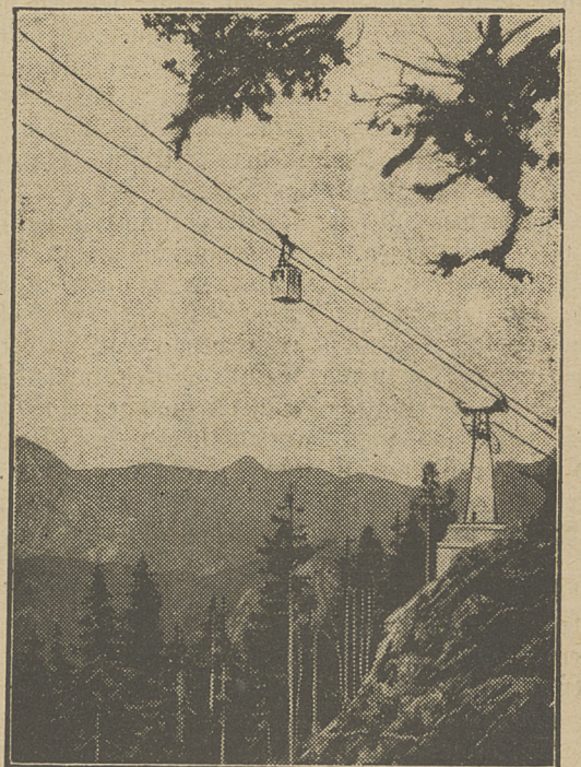
Ein längst gehegter Wunsch ist zur Tat geworden. Der Ausichtsreichste Gebirgsstod des Salzkammerguts wurde mit seiner Talstation Ebensee durch eine Personen-Schwebebahn verbunden. Vom Landungsplatz Ebensee führt die Bahn in einer Teraffe von 2950 Meter hinauf zum Feuerkogel. Die größte Spannweite beträgt 1400 Meter, größte Tiefe 404 Meter.
