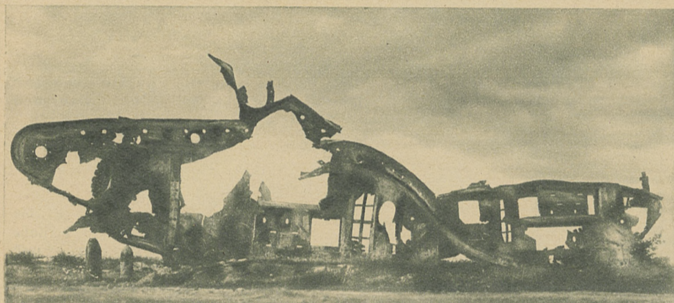
Ein Stahlgespenst. Die Trümmerreste vernichteter Tanks starren noch heute gen Himmel. Die Veröffentlichung dieser Bilder erfolgt nach dem demnächst im Grundsberg-Verlag erscheinenden Buch „Das unsichtbare Denkmal — 10 Jahre später an der Westfront“, von Martin Ziese und Hermann Ziese-Berlinger
