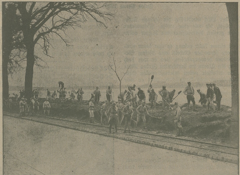
Pioniertruppen errichten Schutzmauern an der Garonne, um die Straßen und Bahnlinien bei Bordeaux gegen die erneute Überschwemmungsgefahr zu schützen.
