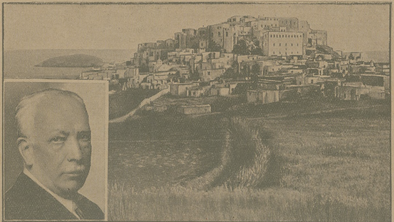
Die griechische Insel Nagos, die Richard Strauß (unten links), den Komponisten der Oper „Ariadne auf Nagos“ zum Ehrenbürger ernannte.
