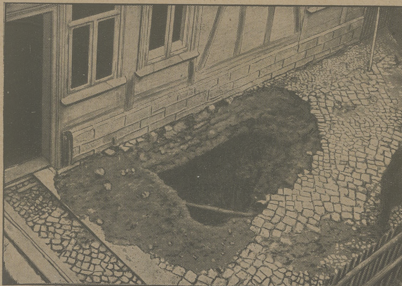
Ein metertiefer Krater in einer Vienenburger Straße, der sich als Folge des Kalligubeneinsturzes neugebildet hat. Ein zufälliger Passant versank in diesem Erdloch und konnte nur mit Mühe schwer verletzt geborgen werden.
