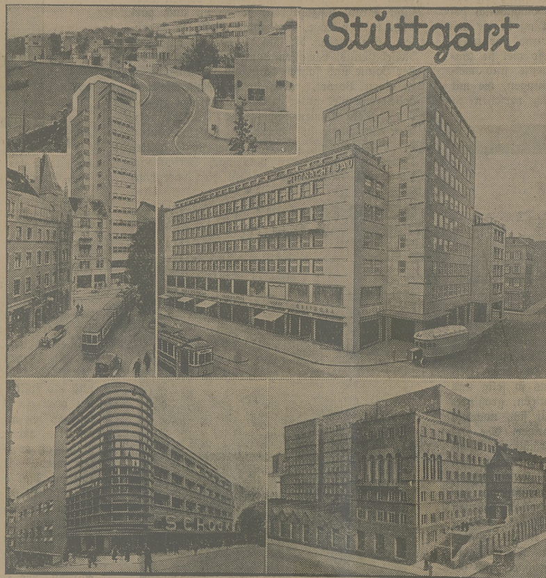
Unten: Links neues Warenhaus von Mendelsohn mit gläsernen Ecktürmen. Rechts Oberpostdirektion, die an eine Hochburg der italienischen Frührenaissance erinnert. Darüber: Links 16-stöckiger Wolkenkratzer einer Tageszeitung. Rechts der Mittnachtbau, ein riesiges Geschäftshaus, das der württembergische Staat errichtete. Ganz oben: Die Weissenhof-Siedlung, an deren Bau die modernsten Architekten Europas mitwirkten.
