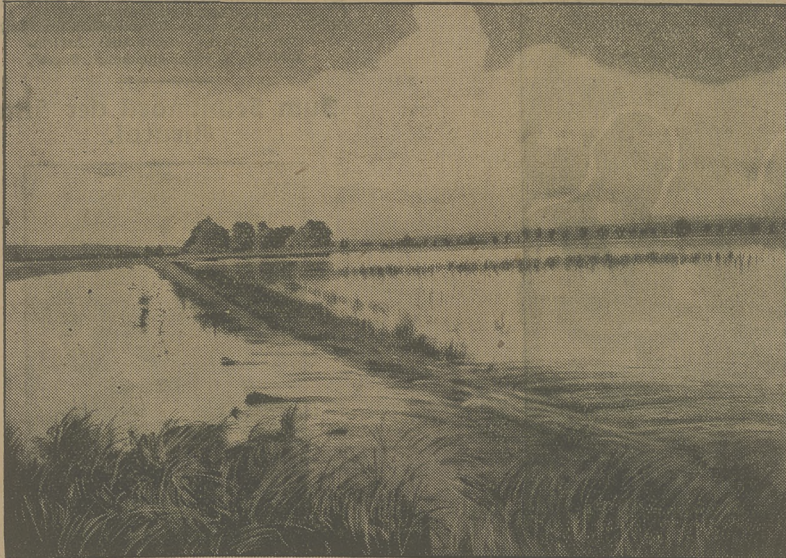
Einer der überfluteten Dämme im Ueberschwemmungsgebiet bei Stade.
