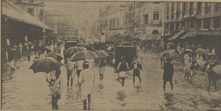
Ein Straßenbild aus Bombay während der Regenperiode. Die schweren Regengüsse der letzten Monate haben alle tiefergelegenen Straßen völlig unter Wasser gesetzt, sodaß der Verkehr schwer behindert ist.
