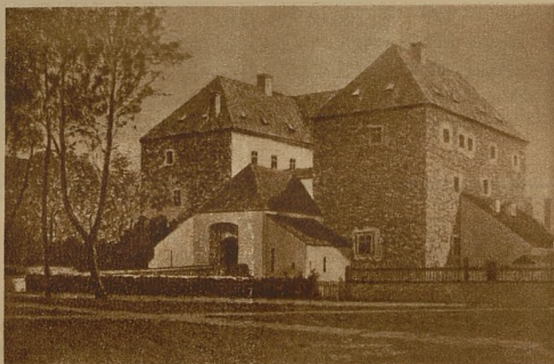
Stare płockie dworzyszczce
