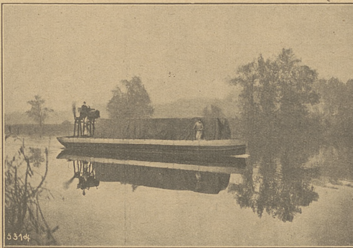
Rys. 104. Ślizgowiec towarowy „De Lambert” 10-tonnowy.
