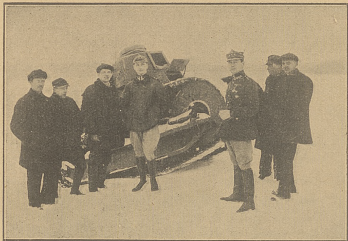
Rys. 123. Kapitan wojsk samochod. Grossman i por. 1 pułku czołgów Kuszelewski podczas prób czołga „Renault” na gąsienicy kpt. Kardaszewicza w zimie 1923—1924 r. Zdjęcia dokonano w okolicy Sulejówka po przejechaniu 329 klm. na nowej gąsienicy.
