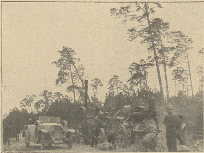
Rys. 204. Widok rzadko, niestety, u nas widziany. Parowa tłućarka przygotowuje materiał do naprawy drogi raidowej.
