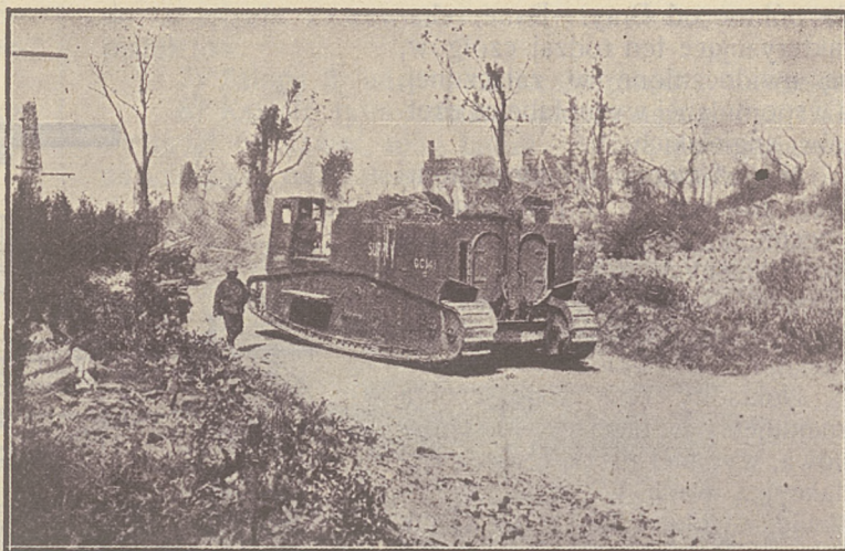
Rys. 289. Angielski czołg „Supply Tank”, służący do zaopatrywania jednostek piechoty i artylerji na polu walki.
