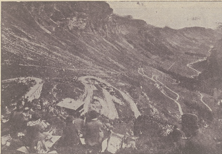
Rys. 359. Niebezpieczne zakręty toru Klausen.
