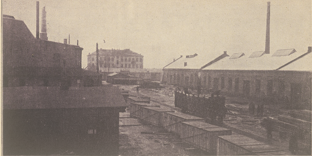
Ogólny widok części hal i zabudowań Centralnych Warsztatów Samochodowych.
