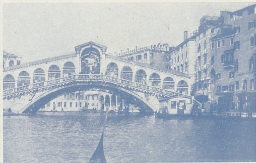
„Ponte di Rialto“
