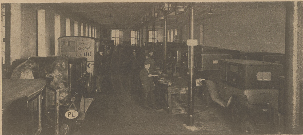
Hala warsztatowa o powierzchni 500 m 2 .
