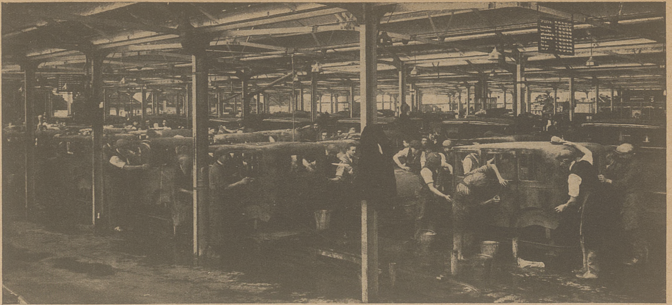
Nadwozia po zagruntowaniu.
