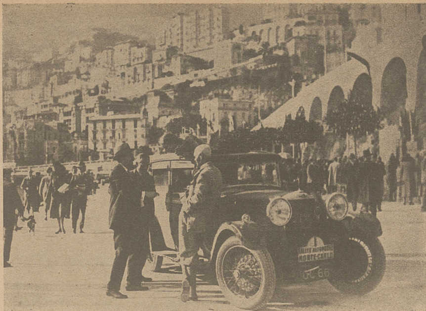
Na mecie w Monte Carlo. Panna Brunell, wyglądając z otworu w dachu swego Talbota, opowiada o przeciwnościach, napotkanych w drodze na Lazury Brzeg.
