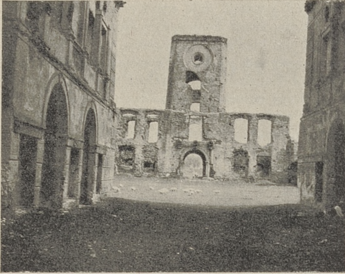
Ujazd — Brama wjazdowa.
