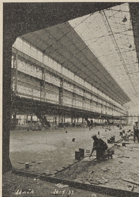
Widok Hali na wykończeniu w 5 miesięcy po rozpoczęciu robót t. j. w dn. 15 września 1933 r.
