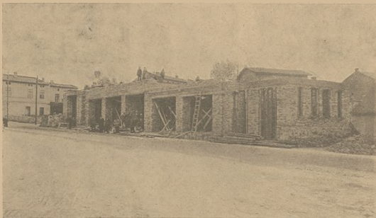
Budowa Domu Legionowego w Jaworznie.
