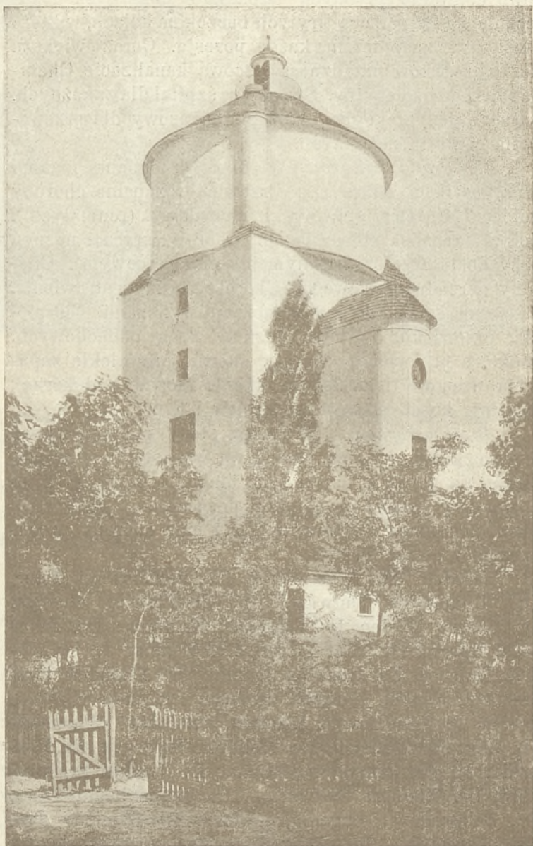
Ciechocinek: — Wieża ciśni.
