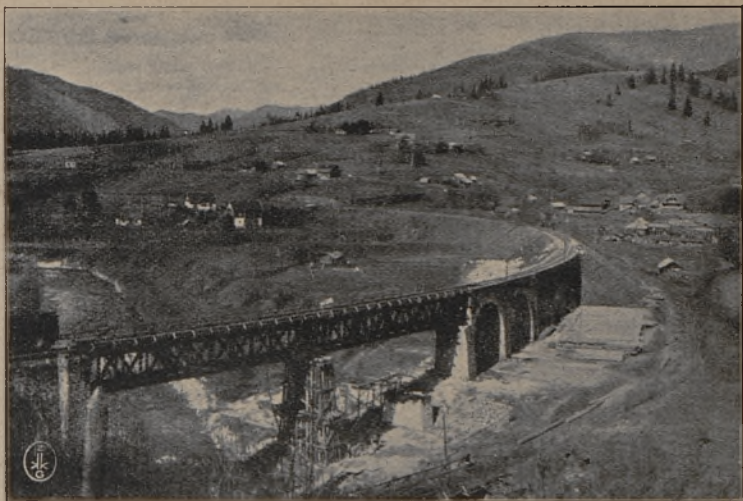
Wiadukt kolejowy w Worochcie.
