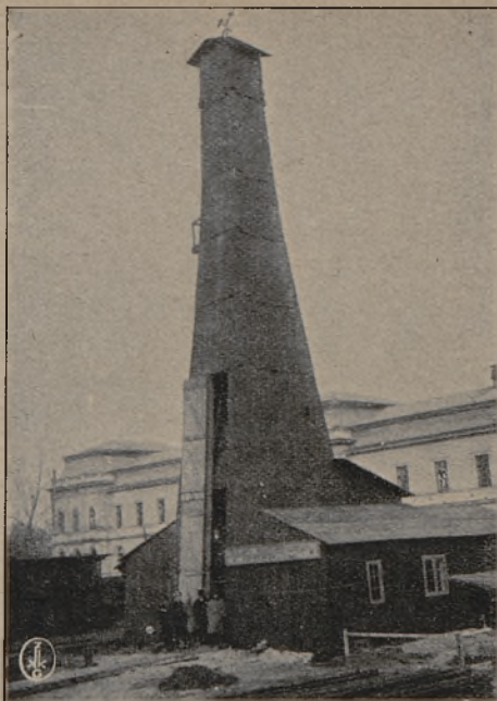
Ciechocinek. — Wieża wiertnicza źródła termalnego.
