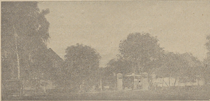
Widok Kolonji w Czyżeminku od strony frontowej.
