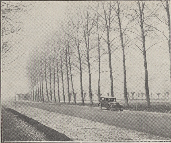
Tor próbny fabryki „Fiat“ o potrójnej nawierzchni.
