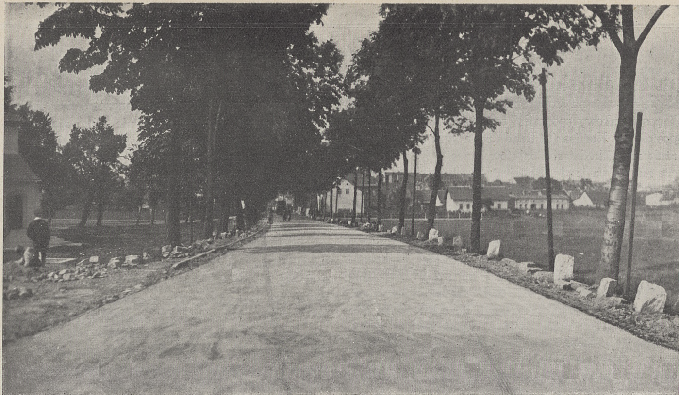
Droga Katowice — Zory. Nawierzchnia asfaltowa systemu Warenit-Bitulitic.
