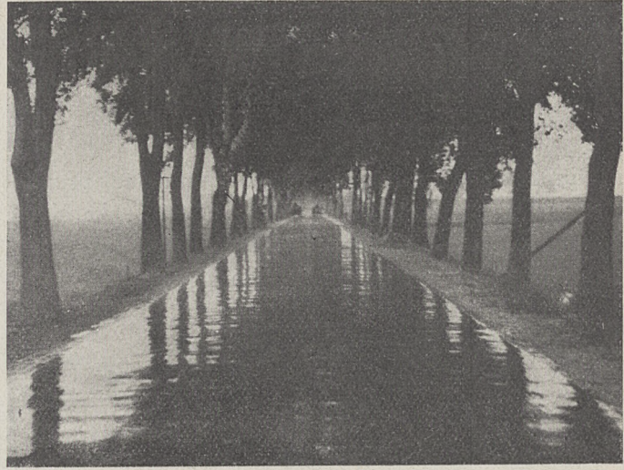
Droga Katowice — Bielsko. Nawierzchnia z betonu asfaltowego.
