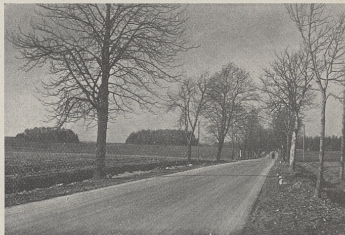
Droga Katowice — Tarnowskie Góry. Nawierzchnia z asfaltu piaskowego.
