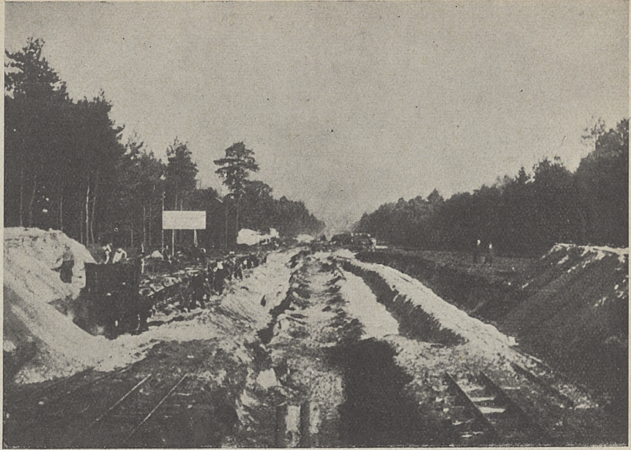
Budowa autostrady Frankfurt n/M — Mannheim w okolicach Darmstadtu.
