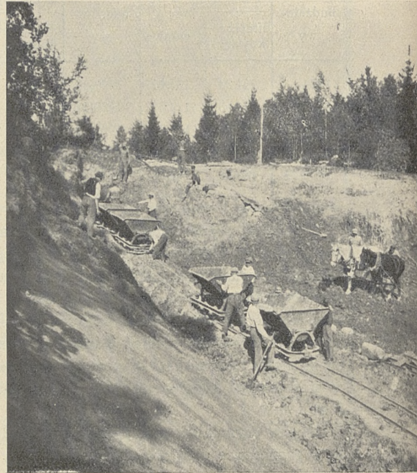
Głębokie wykopy przy budowie dróg.
