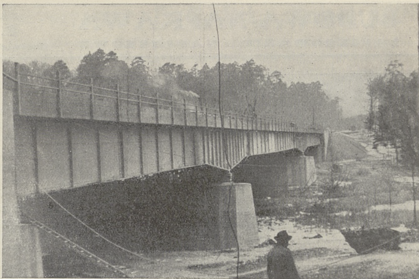
Budowa mostu spawanego na autostradzie koło Berlina.
