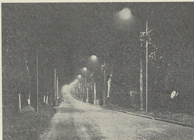
Odcinek drogi Paryż—Riviera oświetlony lampami sodowymi.
