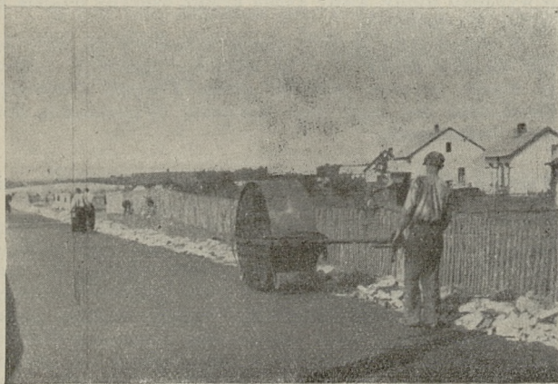
Wałowanie nawierzchni komdrolibowej na drodze Katowice—Kraków.
