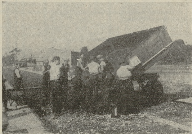
Wyładunek masy asfaltowej przy budowie drogi Kraków—Katowice.
