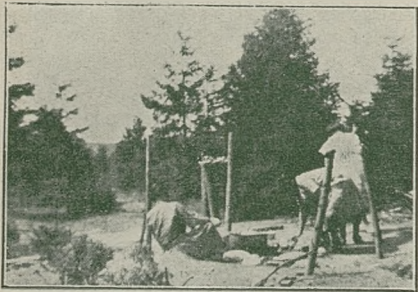
Budowa kuchni (X Warsz.).
